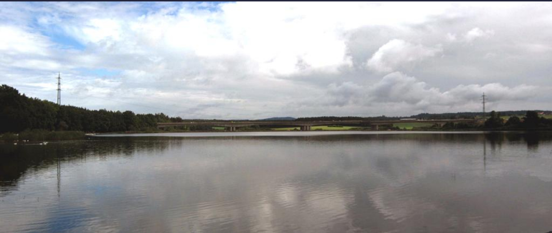
Koberný rybník, vzadu most rozestavěné dálnice
