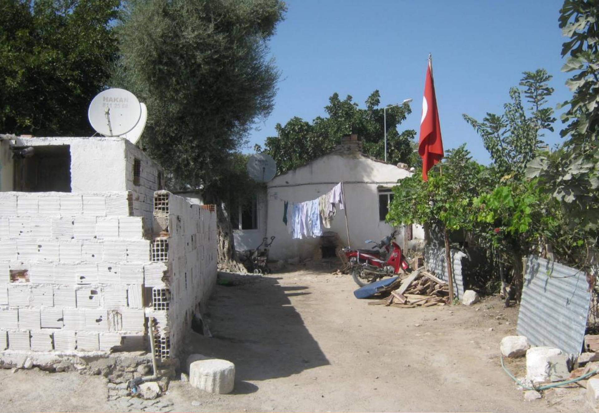
Chatrč + turecká vlajka + satelitní antény + nová motorka + probíhající rekonstrukce výměny oken.
